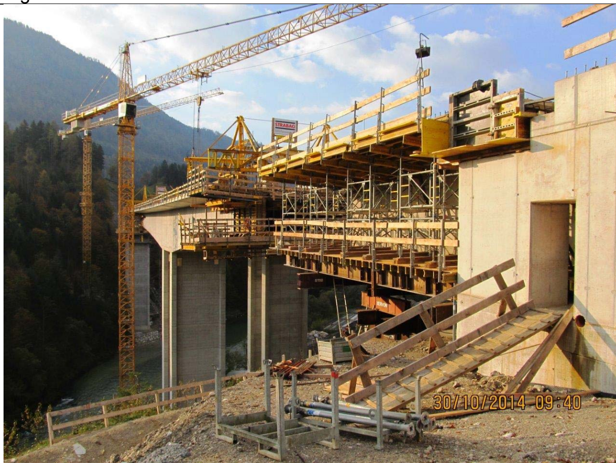
FOTO: Betonieren der Fahrbahn mittels Vorschalwagen
